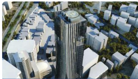
پروژه سپهر الهیه
